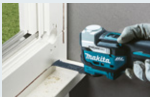
Rimozione cornice della finestra
