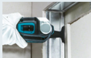
Lavori di apertura porte
