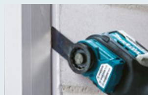
Taglio stucco finestra, silicone
