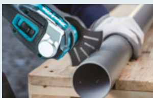
Taglio di tubi in PVC, FRP
