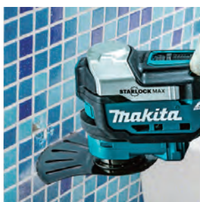
Scanalatura delle fughe su piastrelle da parete
