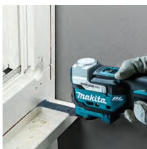
Rimozione del telaio della finestra
